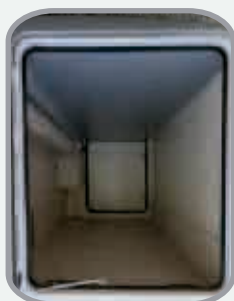
Interior portones incluido la del garaje completamente revestidos en VTR (poliéster reforzado)
